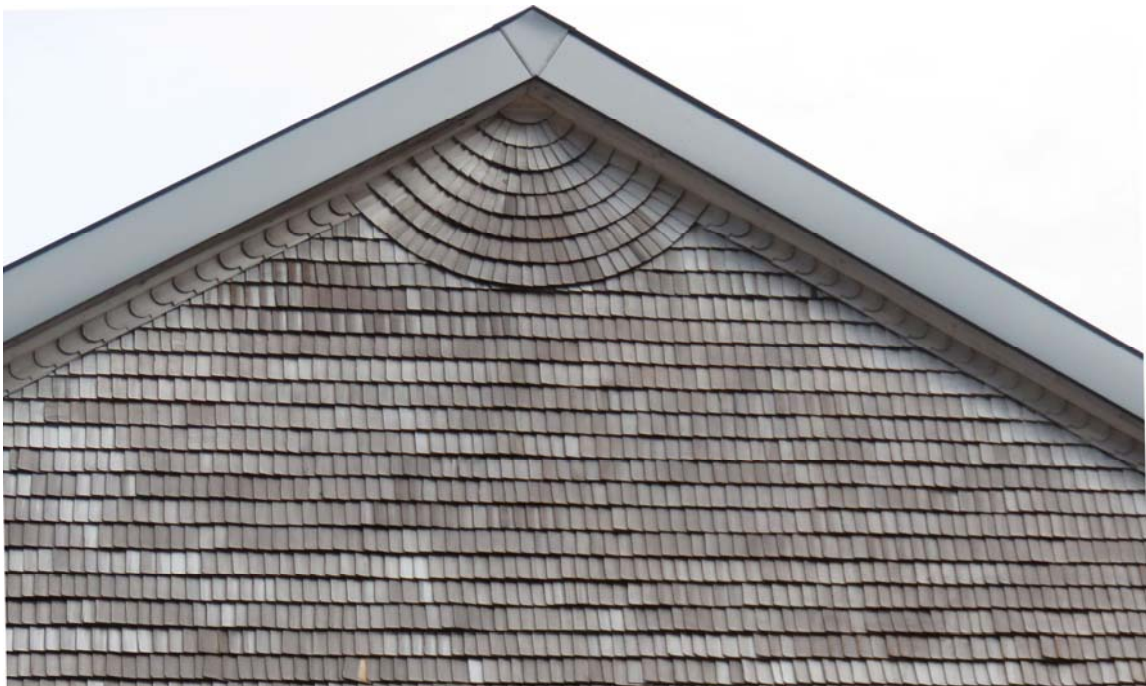
Chalet des Grands Plats de Bise, pignon à vent. Ou quand le tavillonnage devient de l'art.
